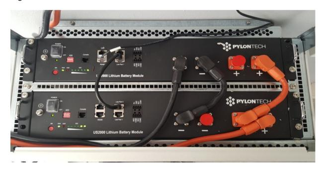
Nel caso in cui l'installazione preveda tre o quattro batterie si rende necessario utilizzare un secondo StorageBox, il collegamento fra le batterie presenti nel primo StorageBox e quelle presenti nel secondo StorageBox dovrà essere effettuato tramite gli appositivi cavi forniti nel Kit ZST-CABLE-0.6M. All'interno del Kit sono presenti n°2 cavi DC per per il collegamento della parte di potenza e n°1 cavo per il collegamento della parte di comunicazione.
